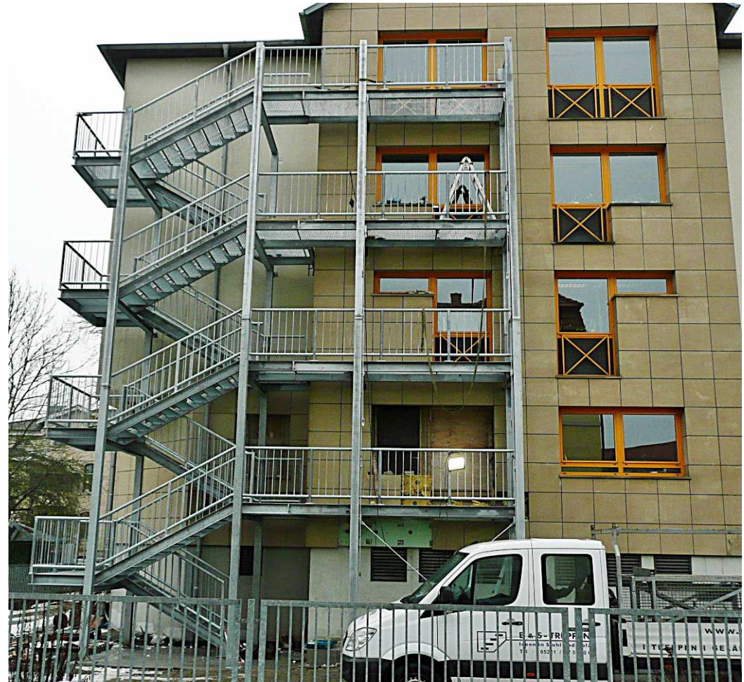
Kurz vor der Fertigstellung ( Dez. 2012 )
